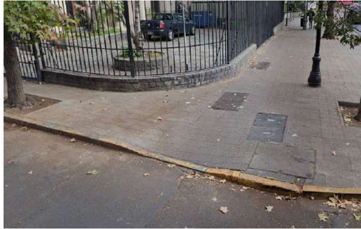
Paso de rodados en la esquina de Eliodoro Yáñez con Triana. Fuente: Google Maps.
