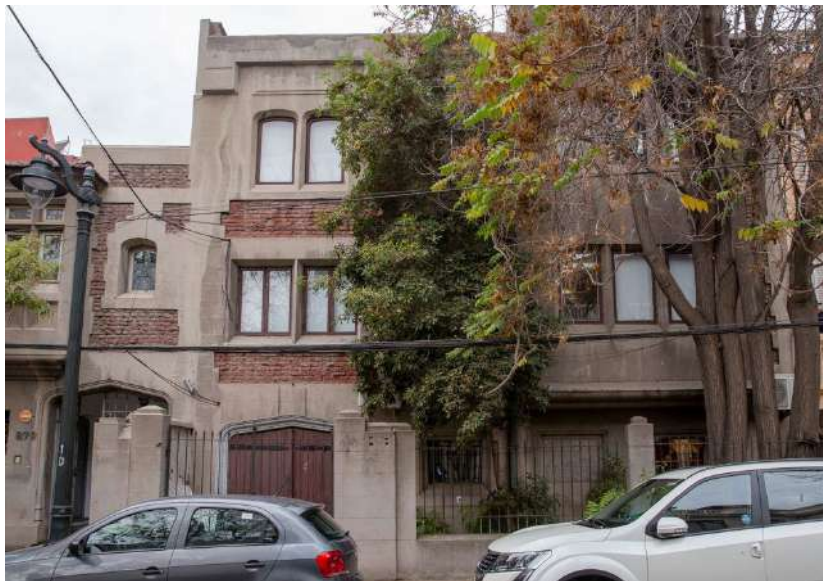
Figura 51 Elevaciones y análisis morfológico de la edificación en Triana 877. Fuente: Elaboración propia, foto de Google Earth.
